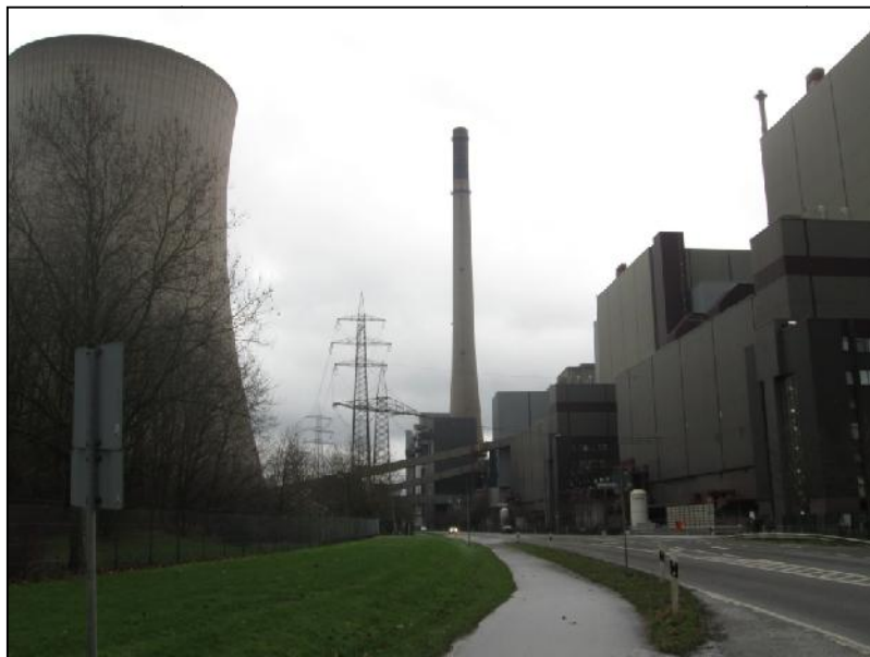
Abbildung 17: Steinkohlekraftwerk STEAG in Voerde
